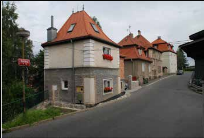
Výstavba mezi lety 1919-1920 Mýtní domek
