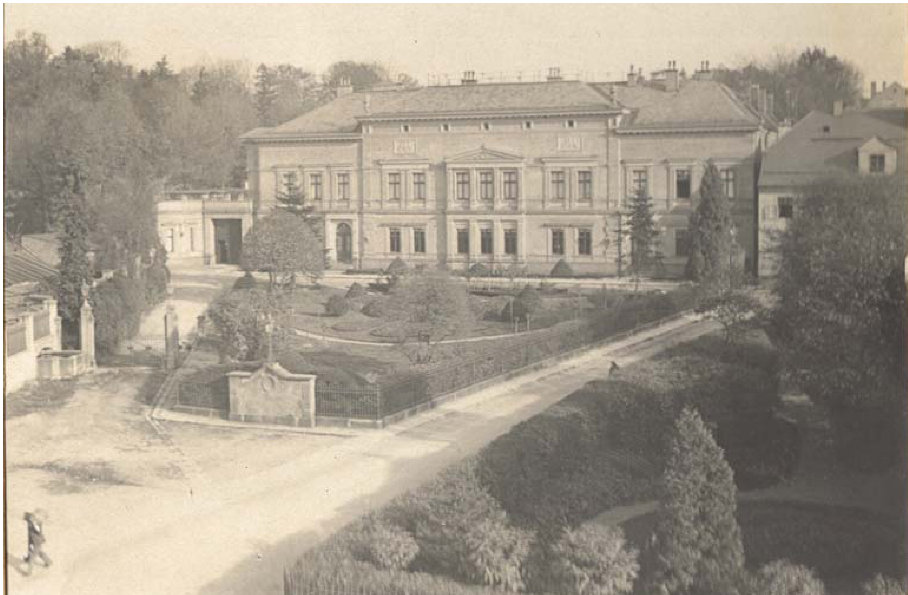
1904: celkový pohled na severozápadní průčelí – pohled k východu
