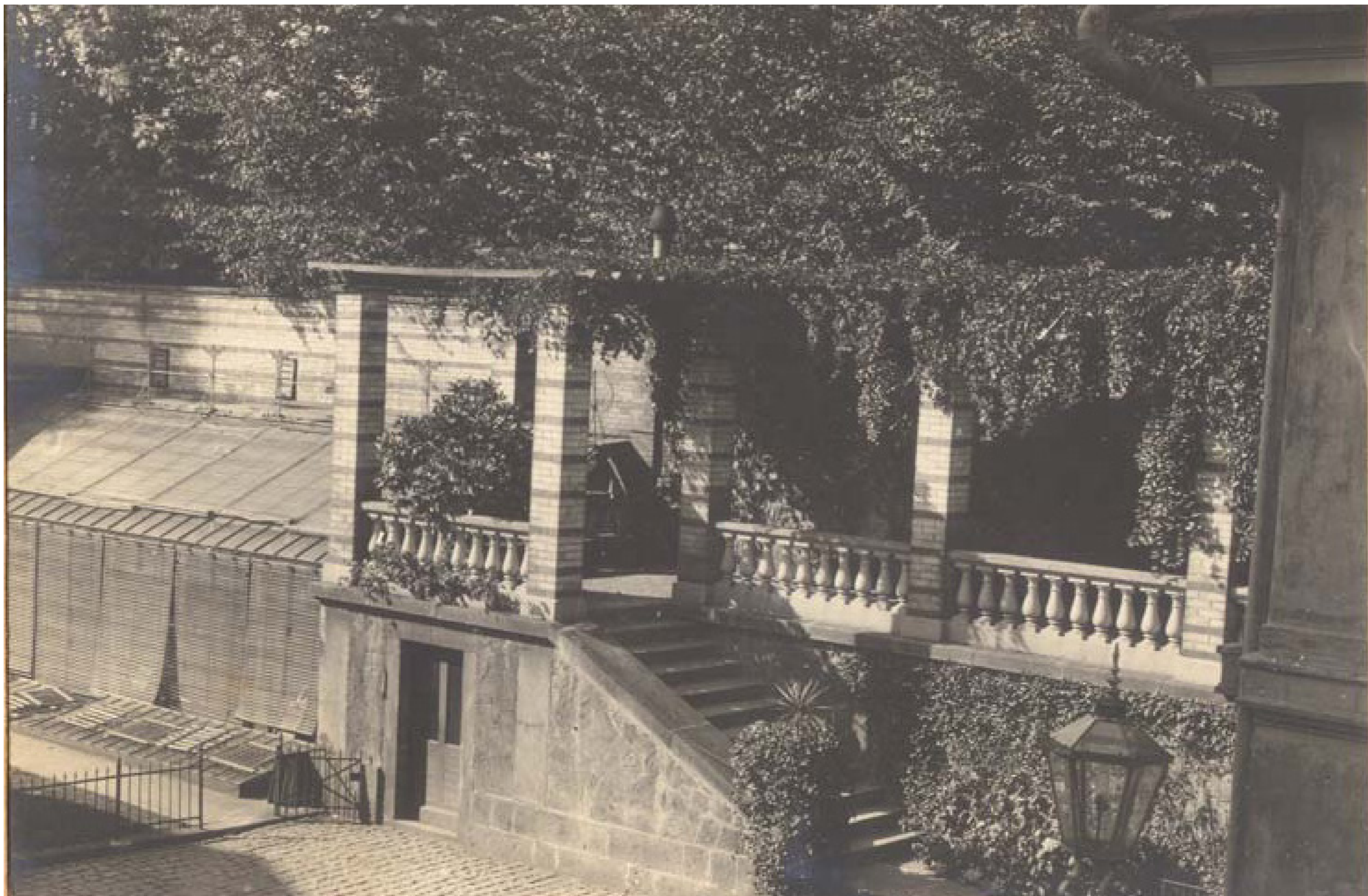
1900: schodiště a pergola nad chodníkem do zahrady + část skleníku
