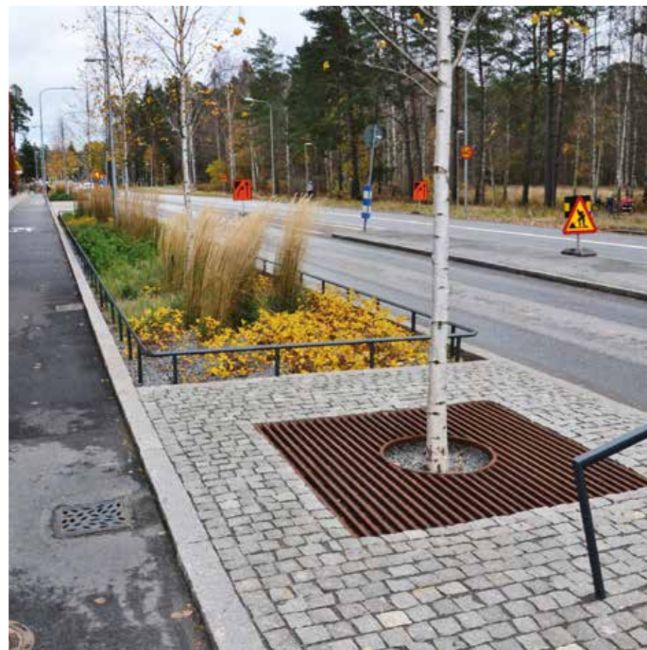
↑ 039 Výsadba stromu ve zpevněné části pásu, Rosendalsova ulice ve městě Vårdsätravägen.
