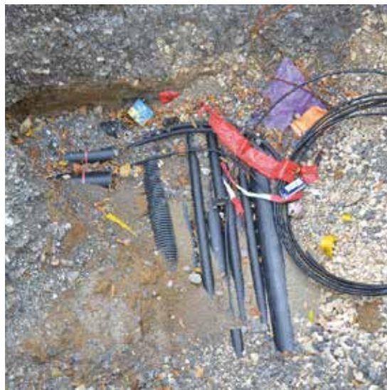
↑ 045 Sdružením podzemních sítí TI v chodníku vzniká prostor pro stromy v ulici. Stuttgart.
