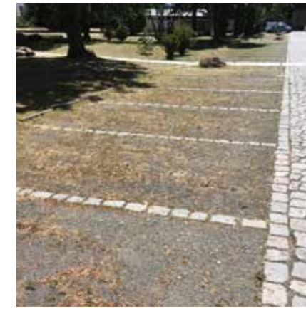
↑ 035 Parkovací stání mají propustný povrch částečně zatravněný zpevněný geomřížkou, pojezděné části jsou dlážděné žulovou kostkou. Cottbus.
