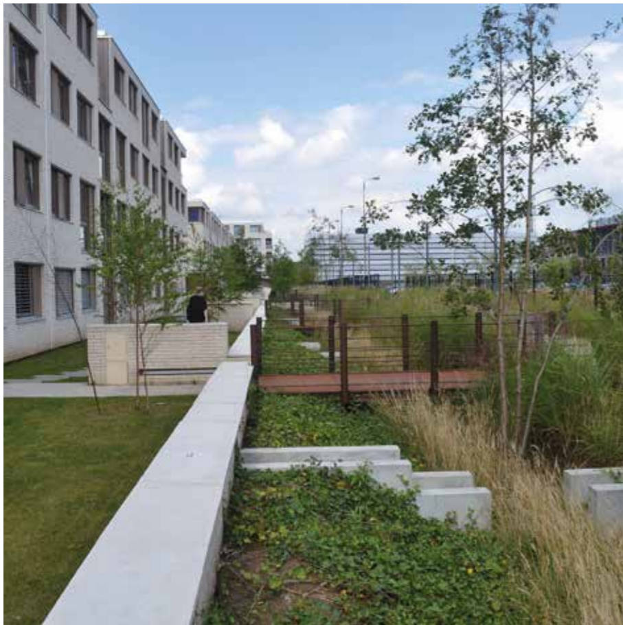
↑ 033 Systém pro zasakování dešťové vody vytváří atraktivní krajinné úpravy v rezidenční čtvrti v Lille.
